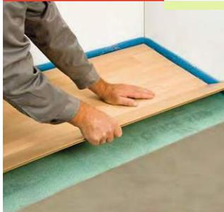
在找平层之上铺上一层消音膜，然后参照生产厂商的指示将表层地板进行铺装。
