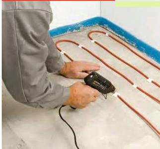
将发热电缆用热熔胶粘结在地面上。如果需要，在地面上涂上一层底料以增强粘性。
