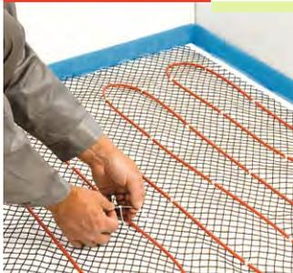
通过计算得到电缆的安装间距，使用电缆扎带将发热电缆绑扎在铁丝网上。
