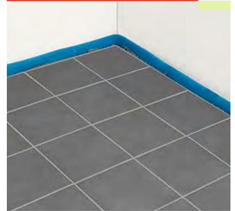
在瓷砖之间和瓷砖与墙壁之间的缝隙之中填入嵌缝剂。待到整个地面完全干燥之后再接通地暖。
