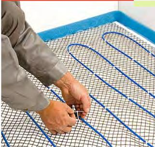
通过计算得到电缆的安装间距，使用电缆扎带将发热电缆绑扎在金属丝网之上。
