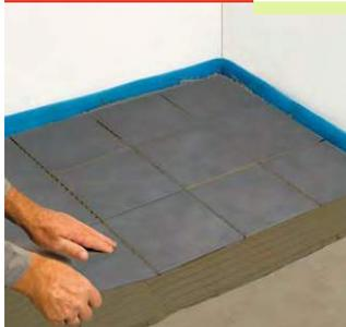
用刮刀将瓷砖粘合剂抹均匀，然后小心地贴上瓷砖。在潮湿区域，在瓷砖粘合剂之前敷上防水层。
