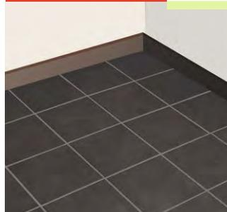
在瓷砖之间和瓷砖与墙壁之间的缝隙之中填入嵌缝剂。待到整个地面完全干燥之后再接通地暖。
