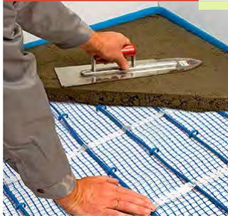
小心地在电缆之上浇筑混凝土，施工方法参照生产厂商的指示。按照混凝土的不同材质，7天~21天后可以开始第一次加热和冷却。
