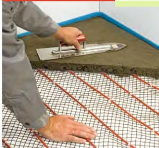
小心地在电缆之上浇筑混凝土，施工方法参照生产厂商的指示。按照混凝土的不同材质，7天至21天后可以开始第一次加热和冷却。
