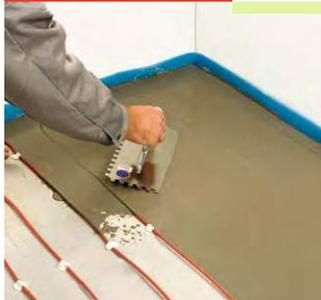
小心地在电缆之上均匀地浇筑混凝土，施工方法参照生产厂商的指示。
